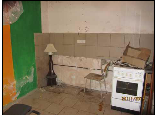
kuchyň ve vestavbě
